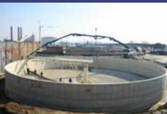
«El suelo de los tanques de sedimentación se moldea en pendiente según las especificaciones del cliente»
