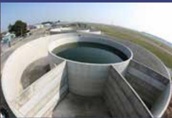
«Los tanques de aireación usualmente se construyen con una altura de 7 m a 10 m para garantizar la absorción más eficiente del oxígeno»
